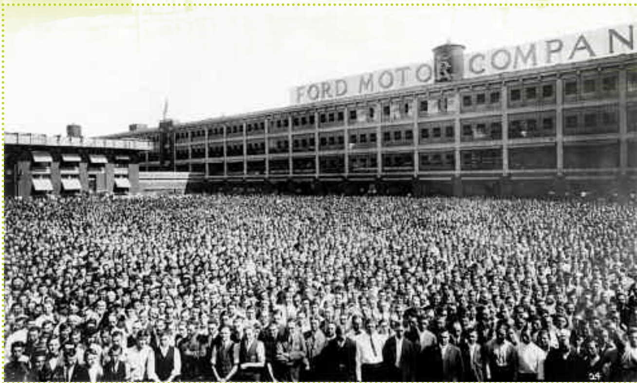
Εργάτες στο εργοστάσιο του Φορντ κατά τη δεκαετία του 1920.
