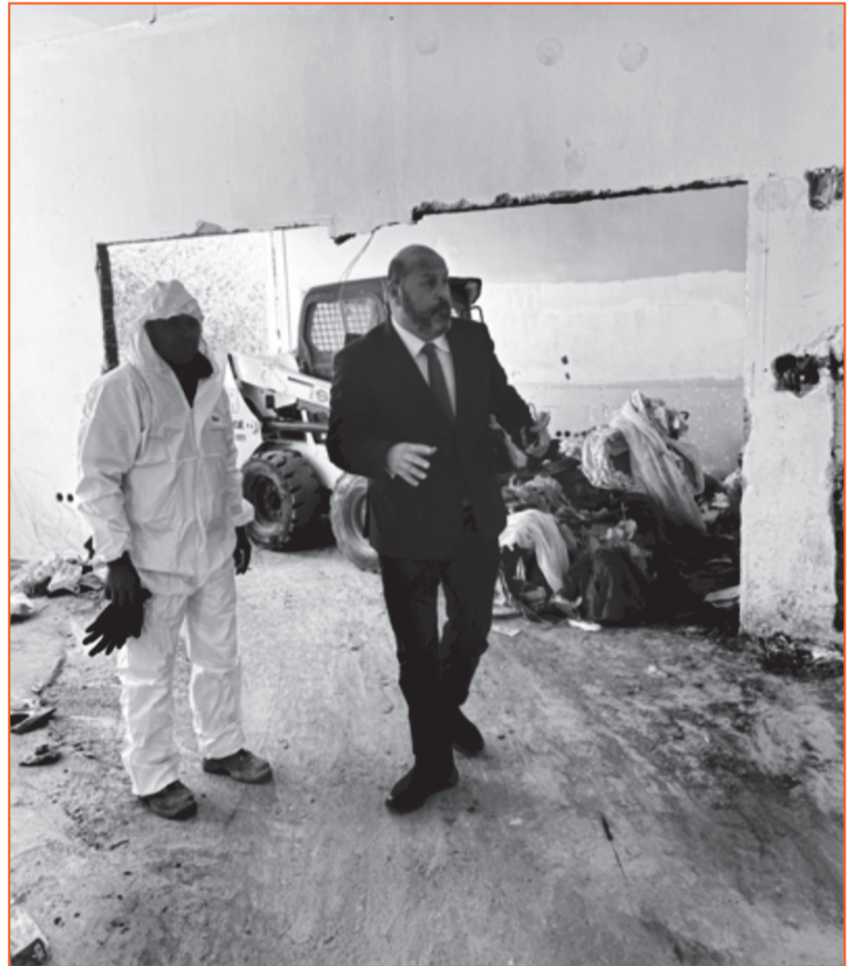
Ο Δήμαρχος Περάματος επιθεωρεί το εγκαταλειμμένο κτίριο του παλιού Σταθμού Πρώτων Βοηθειών στο Πέραμα, μετά την εκδίωξη των Ρομά. Δίπλα του υπάλληλος του Δήμου με στολή κατάλληλη για την αντιμετώπιση υγειονομικών βομβών και πίσω του μια μπουλντόζα που μαζεύει πεταμένα ρούχα και υφάσματα. Όλα μοιάζουν να είναι έτοιμα για να γίνει, επιτέλους, πραγματικότητα το «σύγχρονο Κέντρο Υγείας αστικού τύπου» που οραματίζεται το ΚΚΕ.
